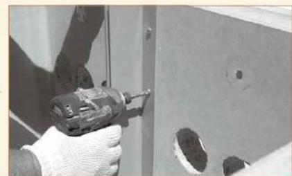
③Fアングルをセットし、ドライバー等でビス(SUS)を締め付ける。
