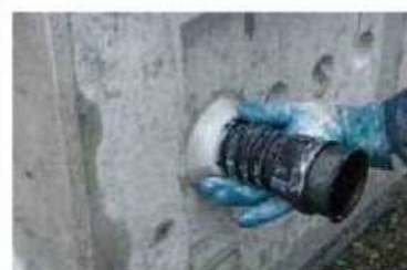
2 エポキシ樹脂にて取り付け (表側)
