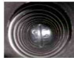
管内部状況(漏水なし)
