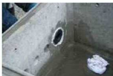
3 エポキシ樹脂にて取り付け (裏側)
