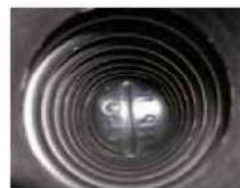
管内部状況(漏水なし)
